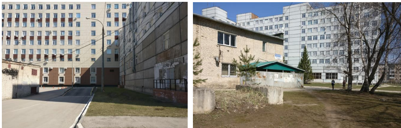
Рис. 6 – Фотофиксация корпусов кампуса ТГУ в Центральном районе г. Тольятти
